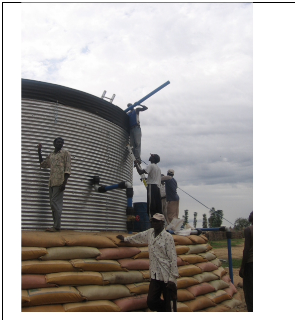
Tanque de distribución de 95.000 litros en y construcción de letrina en el campo de refugiados de Goz Amer
